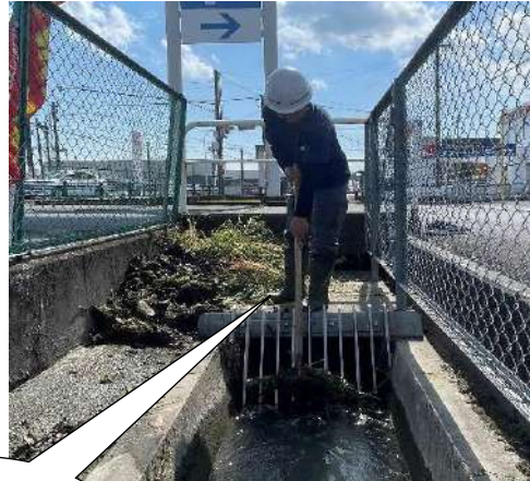
水路ゴミ除去作業
