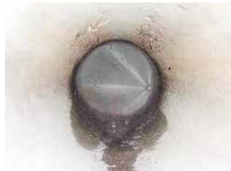
【高圧洗浄作業状況】
