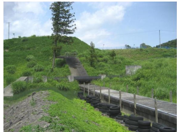
【伊達方発電所建設予定地（掛川市）】
